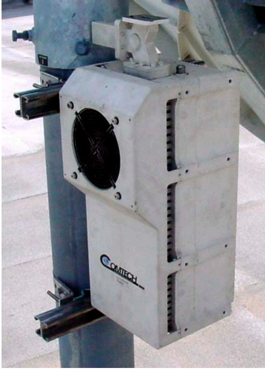
Figure B-6. Install CSAT 50 Watt Unit
