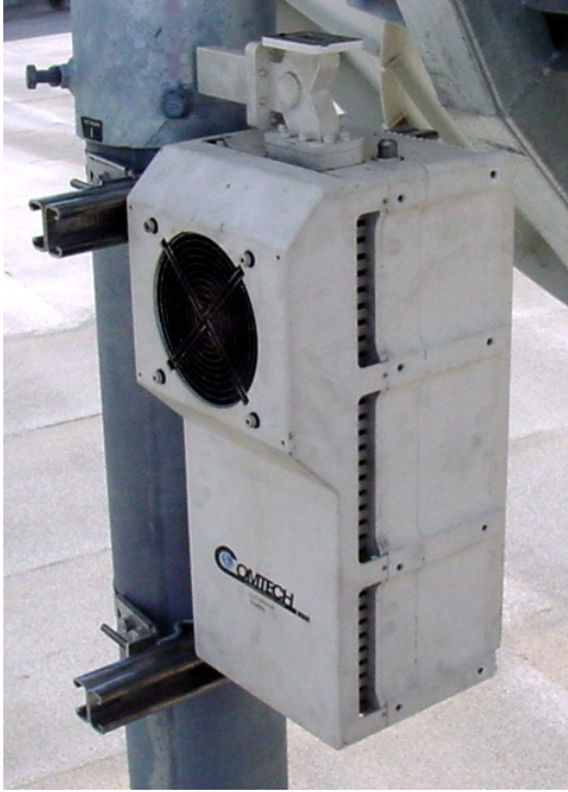
Figure B-6. Install CSAT 50 Watt Unit
