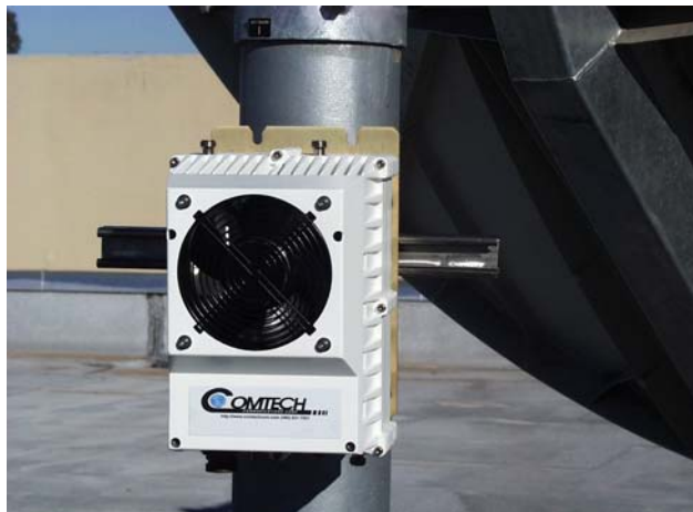
Figure A-8. Mount CSAT Unit
